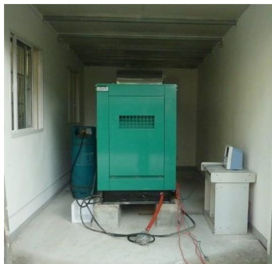
图 1-6 50 kW 燃气发电机
